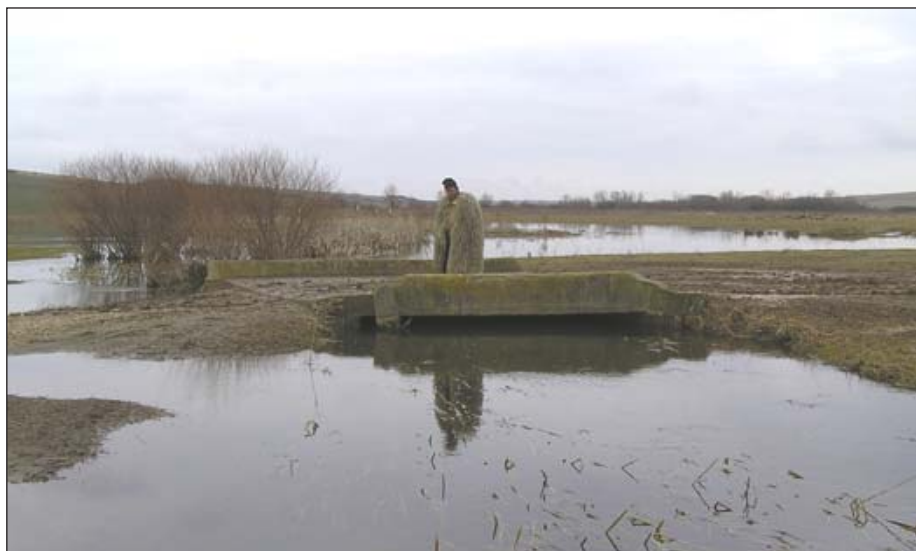
7 Podul de beton.
